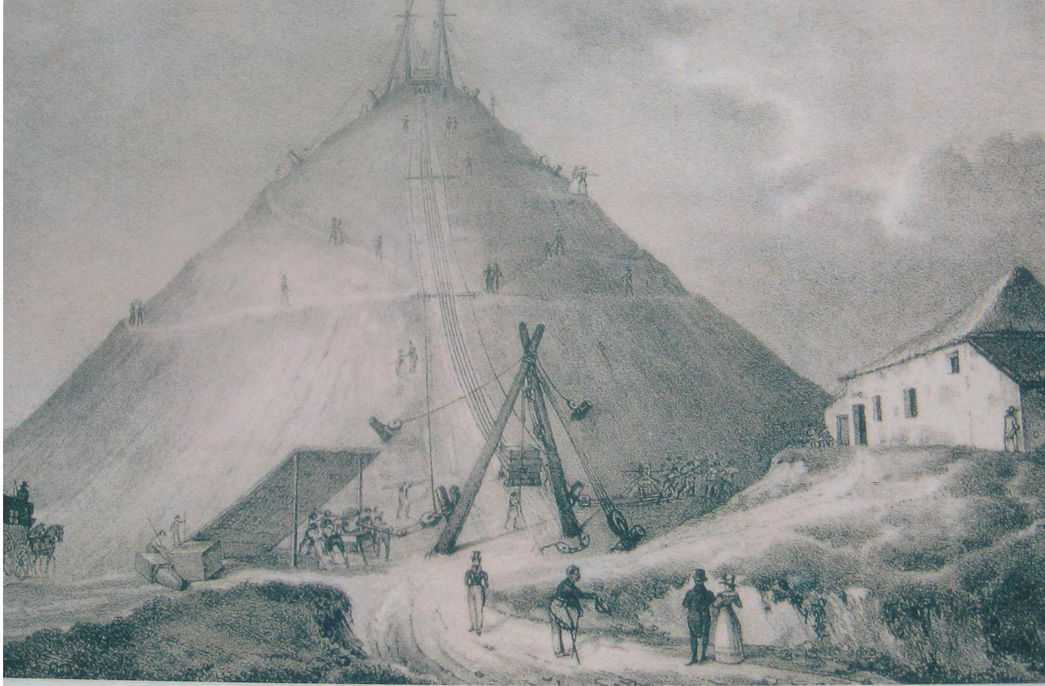
Appareil servant à l'élévation du Lion de Waterloo. Lithographie de Jobard, d'après Bertrand
